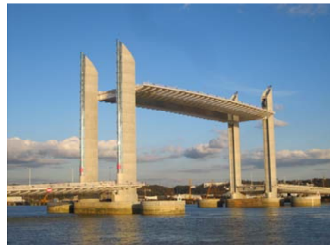
Nouveau pont Chaban Delmas
